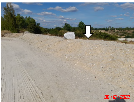
รูปที่ 13 คั่นทำนบดินรอบพื้นที่ลานกองแร่
